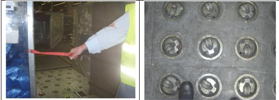
Abbildung 1: Verziehen eines Frachtcontainers einhändig auf einem Rollerdeck mittels einer Zugschleufe (links) sowie Sicht von oben auf die im Boden eingefügten Rollen eines Rollerdecks am Flughafen Frankfurt am Main (rechts Ausschnitt: ca. 0,8 m x 0,8 m)
